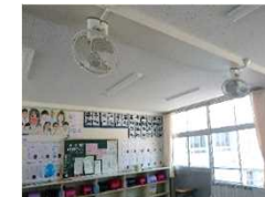
空調のない教室 （扇風機）
