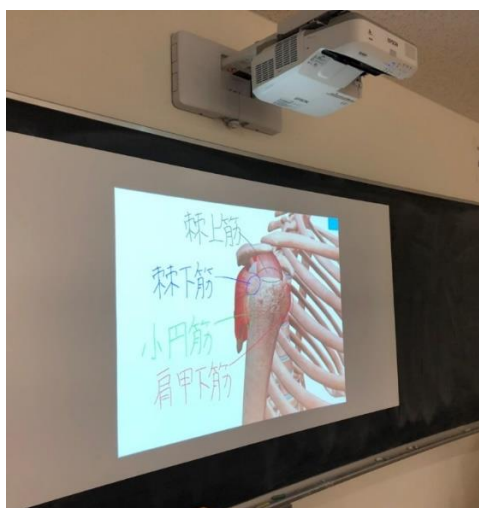
図1：壁掛け電子黒板使用例
